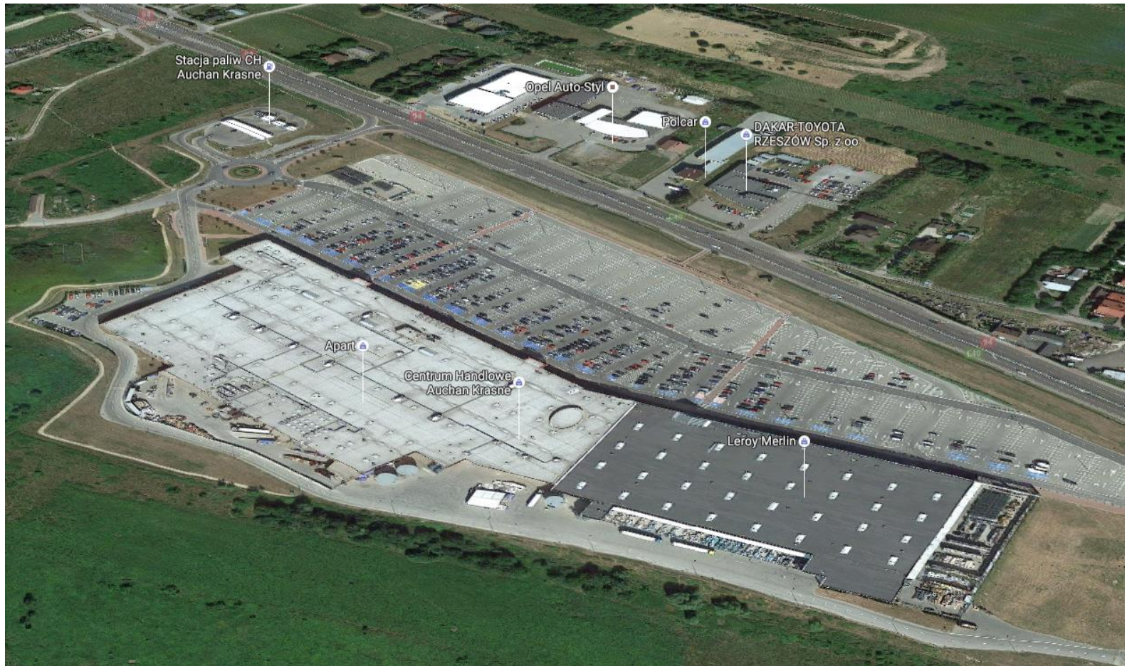
Zabudowa usługowo-handlowa (Krasne koło Rzeszowa)
